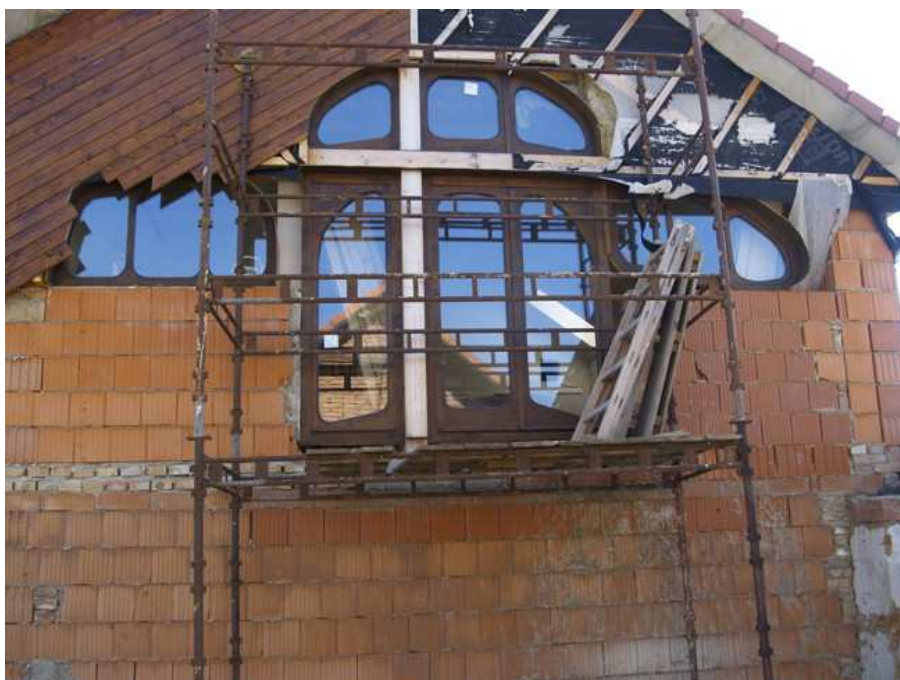
Vinduer/balkongdører i gavlen(terrasse foran fortsatt mangler)
